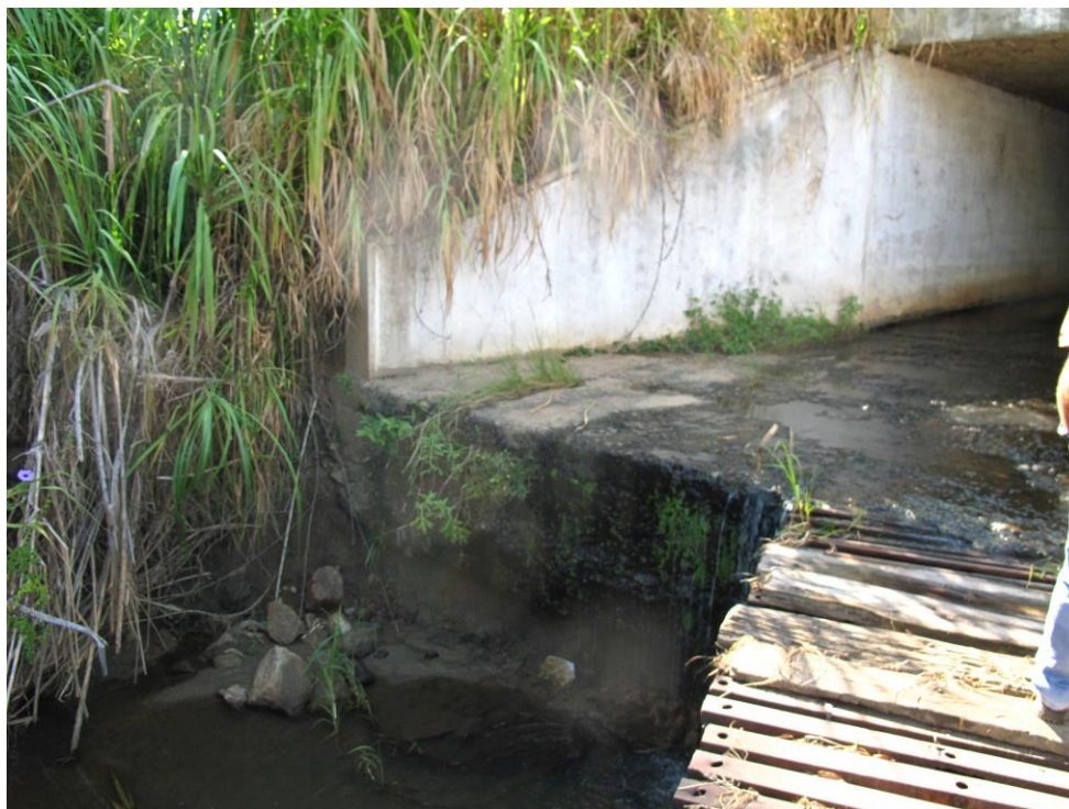
Figura 28: Estrutura antrópica, utilizada como acesso a uma propriedade rural, impedindo o fluxo do ribeirão da Lapa, que nasce dentro do PE Sete Salões, próximo à sua confluência com o Rio Doce
